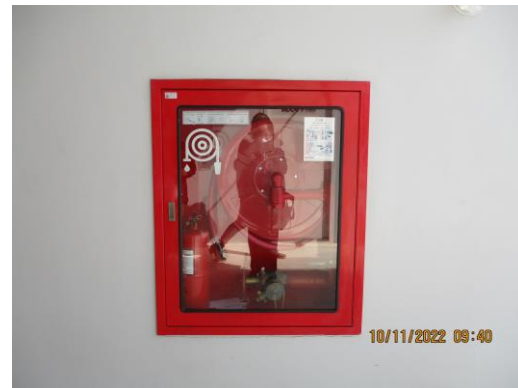
รูปที่ 1-23 ตู้เก็บสายฉีดน้ำดับเพลิงพร้อมอุปกรณ์
