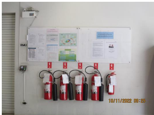
รูปที่ 1-24 ถังดับเพลิงเคมี ชนิด CO 2
