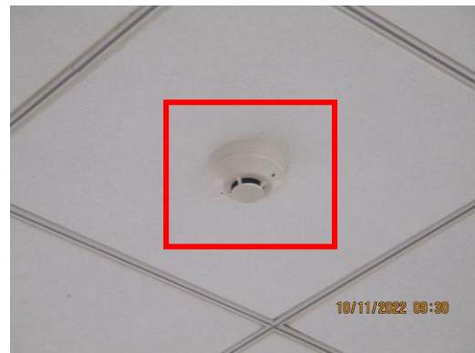
รูปที่ 1-29 เครื่องตรวจจับควัน
