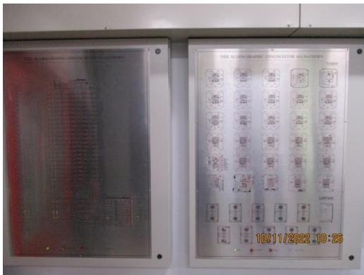
รูปที่ 1-26 แผงควบคุม Fire Alarm
