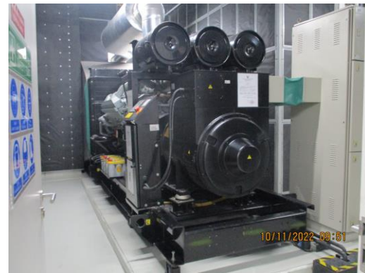
รูปที่ 1-19 ระบบไฟฟ้าฉุกเฉิน
